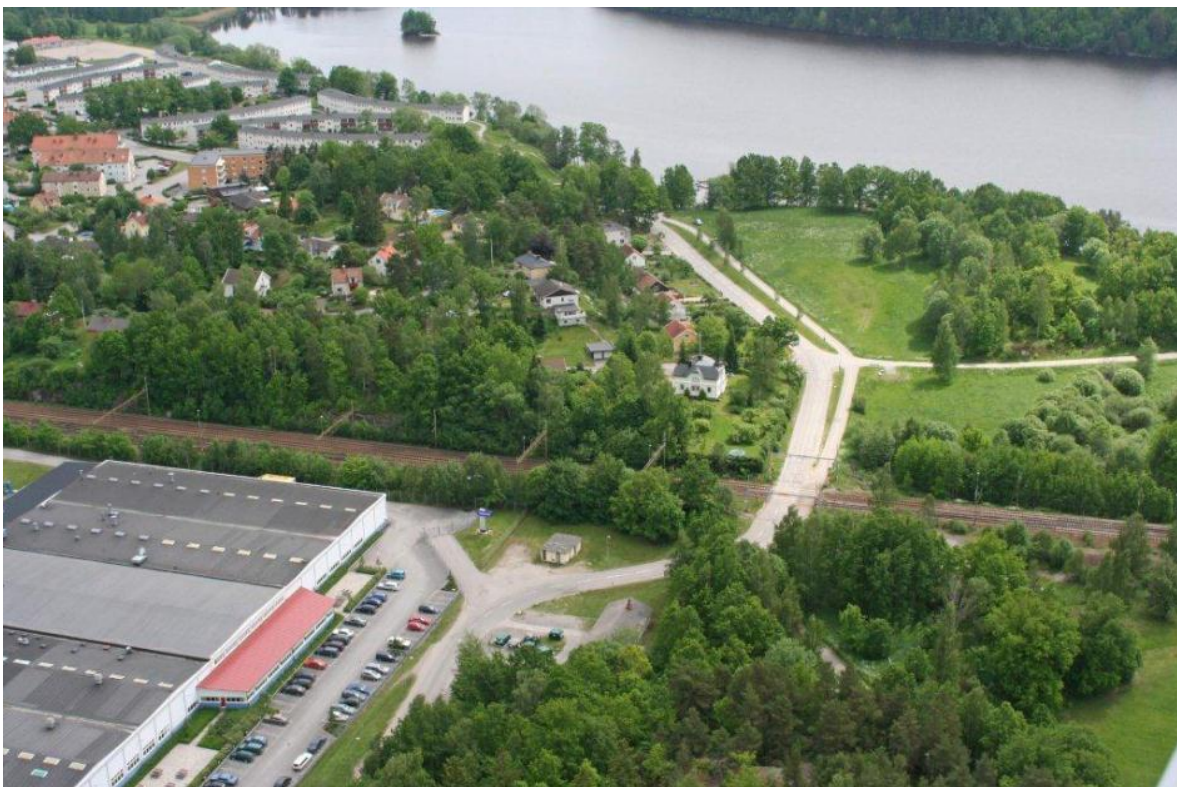
Järnvägsövergången sett från norr
