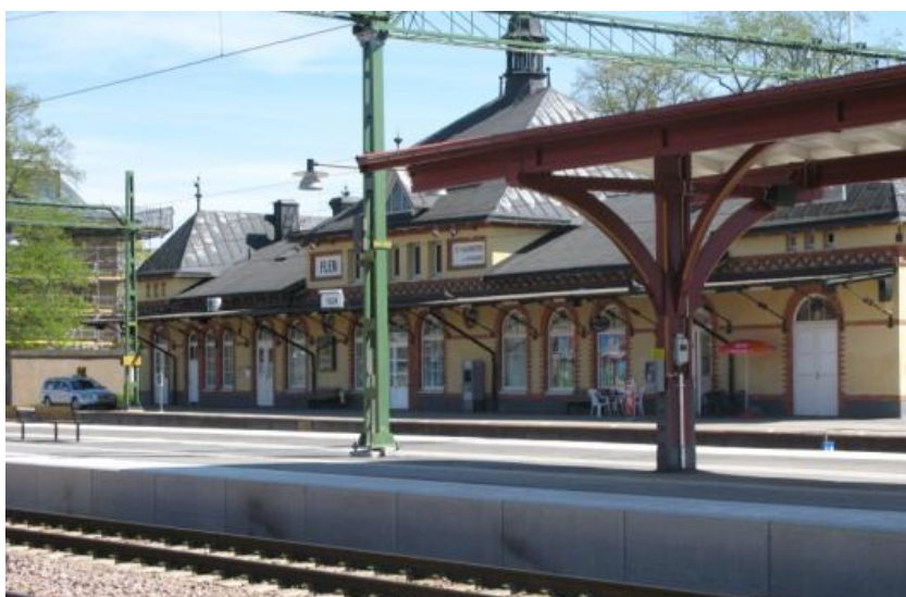
Stationsbyggnaden samt ett av de tre perrongtaken. Både stationsbyggnaden och perrongtaken är skyddade som byggnadsminne.
