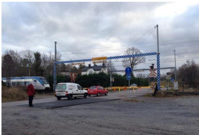
Järnvägsövergången vid Variagatan
