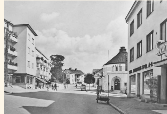
Södra Kungsgatan, vy mot banken, det välkända landmärket från 1901. Byggnaden användes till bankverksamhet i drygt hundra år och är idag q-märkt. På höger sida syns neonskylten över ingången
