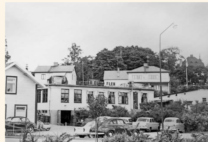
Längre ner på Södra Kungsgatan, hamnar en verkstad mitt i blickfånget. 1948 registreras AB ELMO och har ungefär 35 anställda. Riktmärket här är fastigheten med det svarta taket
